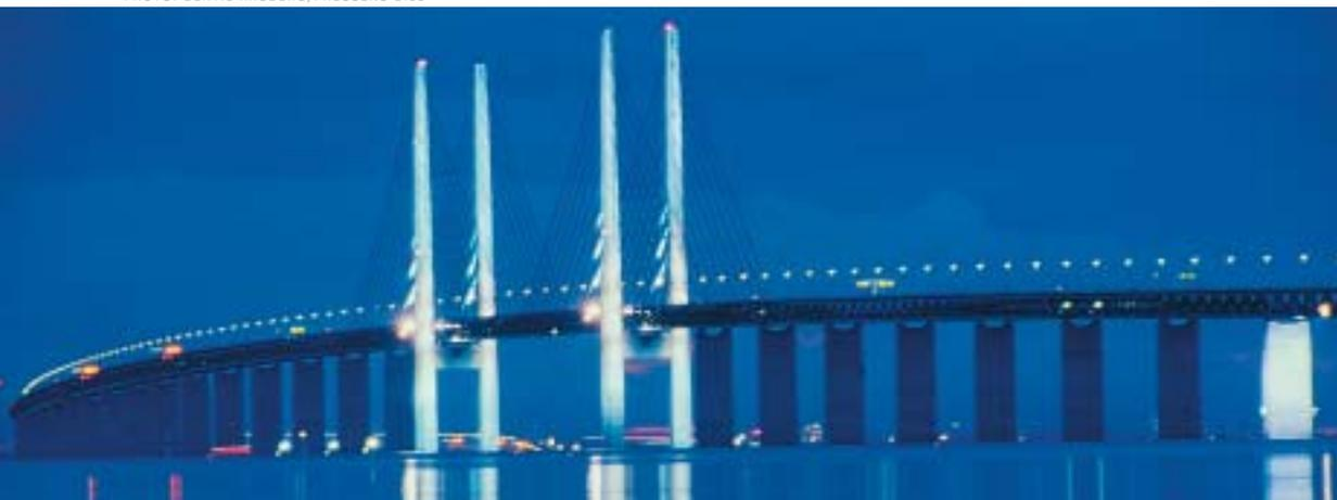
**Орезундский мост, соединяющий Швецию и Данию, протяженность 7,7 км был введен в строй первого июля 2000 года. Общее количество цемента, использованного при возведении моста, составило 320 000 т.**
