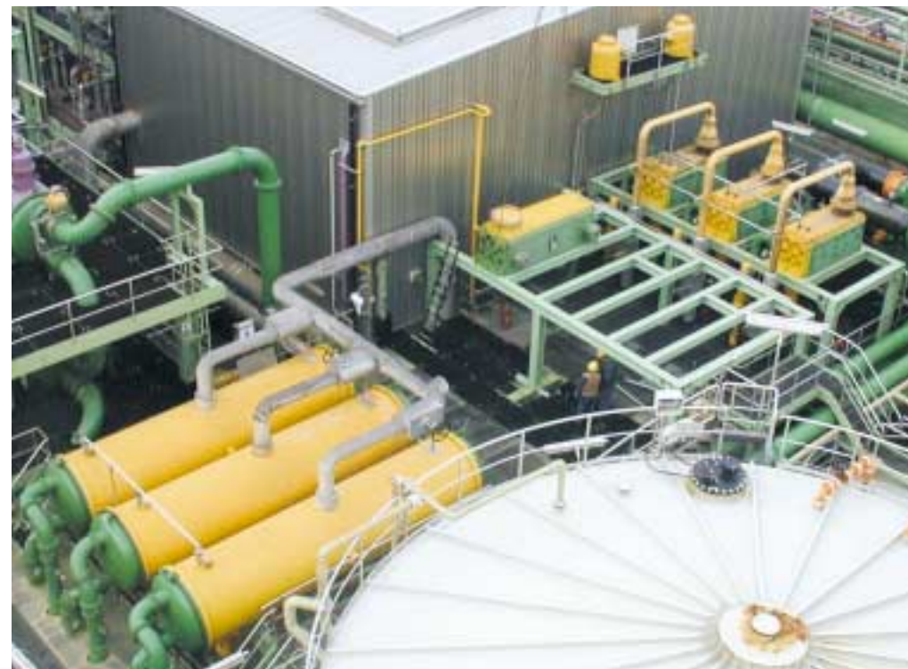
Слева - три кожухотрубных теплообменника, справа - три конденсатора Компаблока. На фотографии видно, насколько компактнее выглядит Компаблок
